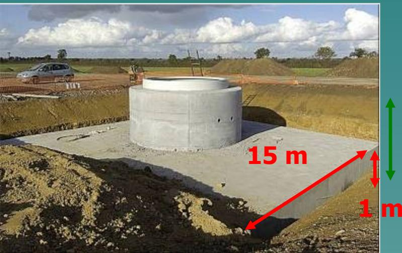
Il faut environ  $300\text{m}^3$  de béton pour les fondations des plus grandes éoliennes, soit 750 tonnes, qui ne sont pas « à jamais coulées dans le sol » mais enlevées, lors du démantèlement du parc éolien, dans leur partie supérieure pour ne pas gêner l'agriculture. Le reste des fondations n'est pas plus mauvais pour l'environnement que les horizons du sol que l'on trouve à ces profondeurs.
